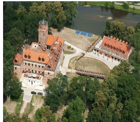
Ryc. 2. Rewitalizacja zespołu zamkowo-parkowego w Uniejowie. Źródło: [24, fot. A. Tomkiewicz]
