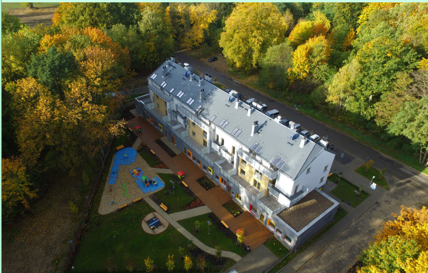
Fot. 5. Budynek mieszkalny Stargardzkiego Towarzystwa Budownictwa Społecznego (położony przy ul. Śniadeckiego 17abc, oddany do użytku w 2020 r.)
