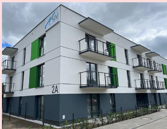
Fot. 1. Budynek SIM KZN Wielkopolska w Ostrowitem
